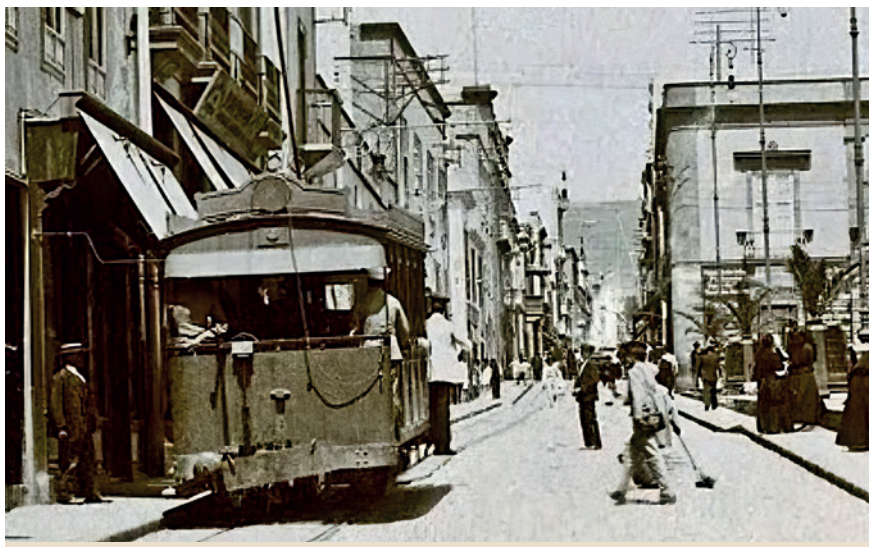
Figura 6. El tranvía en la calle del Castillo, a la altura de la plaza de La Constitución. https://www.eldia.es/santa-cruz-de-tenerife/2021/04/04/tiempos-viejo-tranvia-46074608.html
